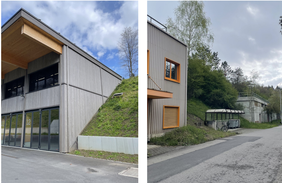
Abb. 10: Neue Fahrzeughalle (links) und designierter Standort Batterieprüflabor (Veloständer, rechts) (April 2024)
